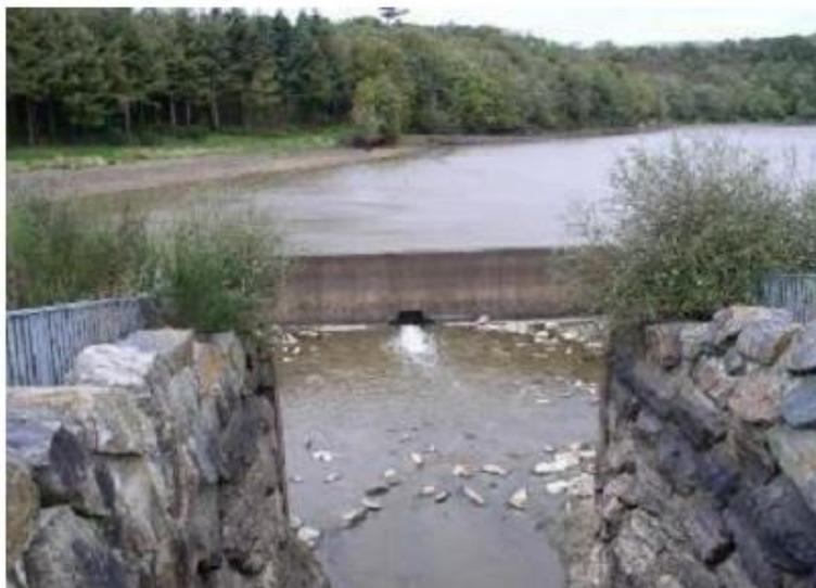
Figure 5. Seuil et vanne de régulation de la retenue de la Baudrière.
